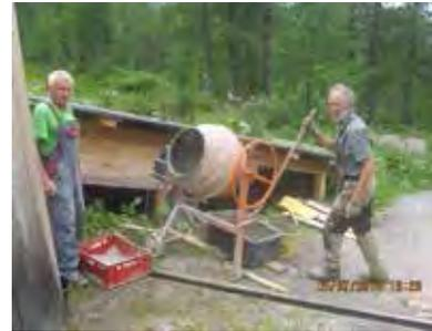
**Betonieren des Fundamentes an der Talstation der Materialseilbahn**
