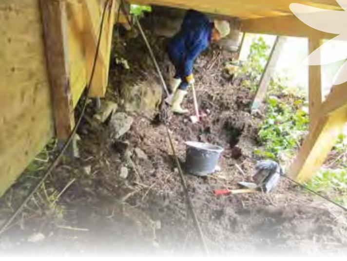
**Die Ausschachtung des Fundaments an der Talstation der Materialseilbahn**
